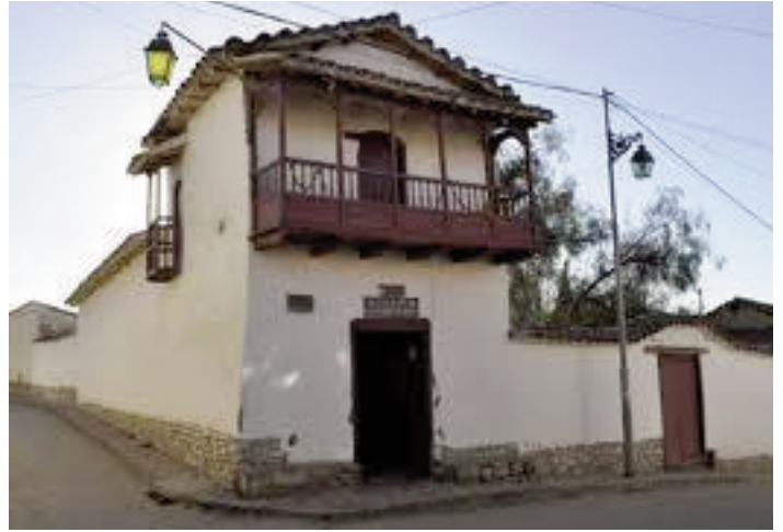
Vista frontal de la casa del "Moto" Méndez
